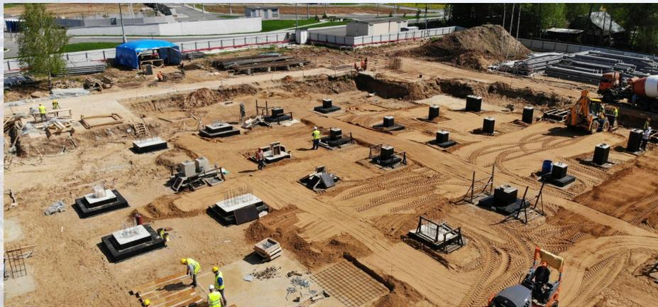
**ВЕДУТСЯ РАБОТЫ ПО ОТЛИВКЕ И ГИДРОИЗОЛЯЦИИ БЕТОННЫХ
