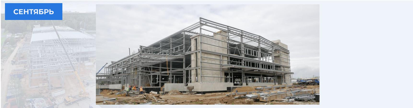
НАЧАТЫ **МОНТАЖ МЕТАЛЛОКОНСТРУКЦИЙ** АДМИНИСТРАТИВНО-БЫТОВОГО КОМПЛЕКСА И **КРОВЕЛЬНЫЕ РАБОТЫ** НА ОПЫТНО-ПРОИЗВОДСТВЕННОМ УЧАСТКЕ
