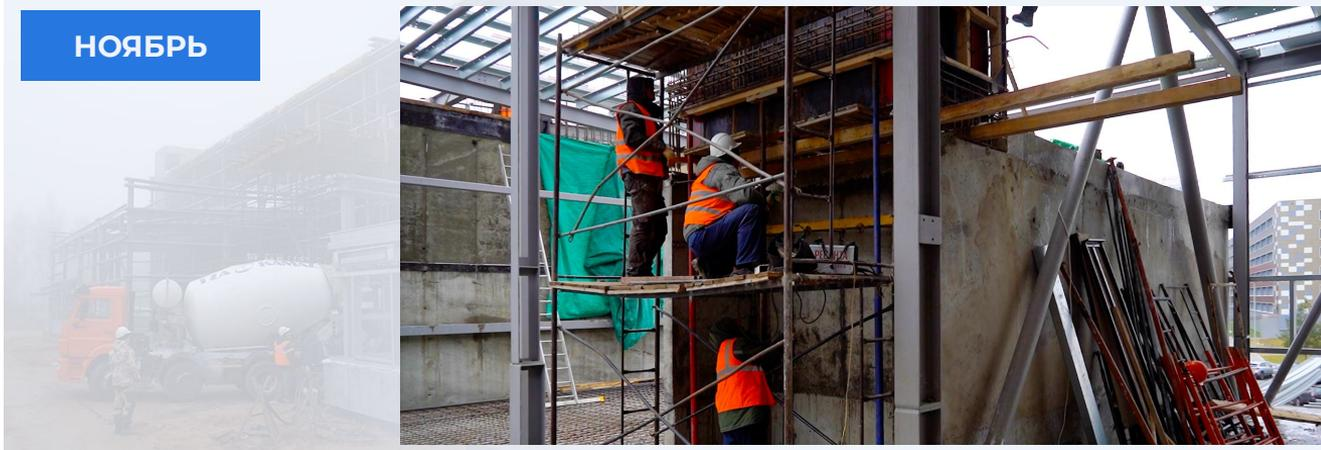
**НАЧАТ МОНТАЖ ОГРАЖДАЮЩИХ КОНСТРУКЦИЙ — ВНУТРЕННЕЙ ЧАСТИ
