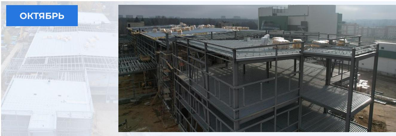
**ЗАВЕРШЁН МОНТАЖ МЕТАЛЛОКАРКАСА ПКТБ.**
