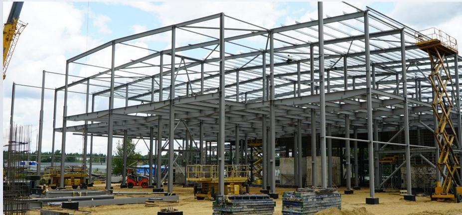
ВЕДЁТСЯ **МОНТАЖ МЕТАЛЛОКОНСТРУКЦИЙ** НЕСУЩЕГО КАРКАСА ЗДАНИЯ,
