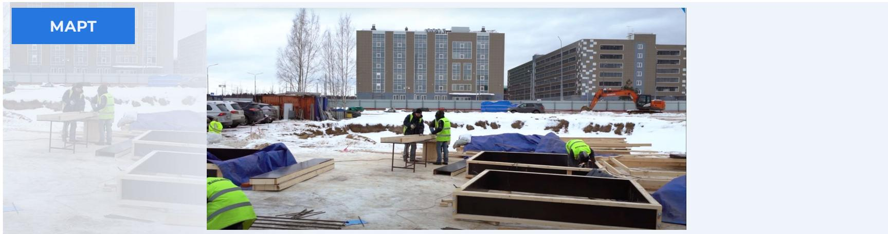
**ВЫПОЛНЕНЫ ПОДБЕТОНКА, АРМОКАРКАСЫ, ОПАЛУБКА**
